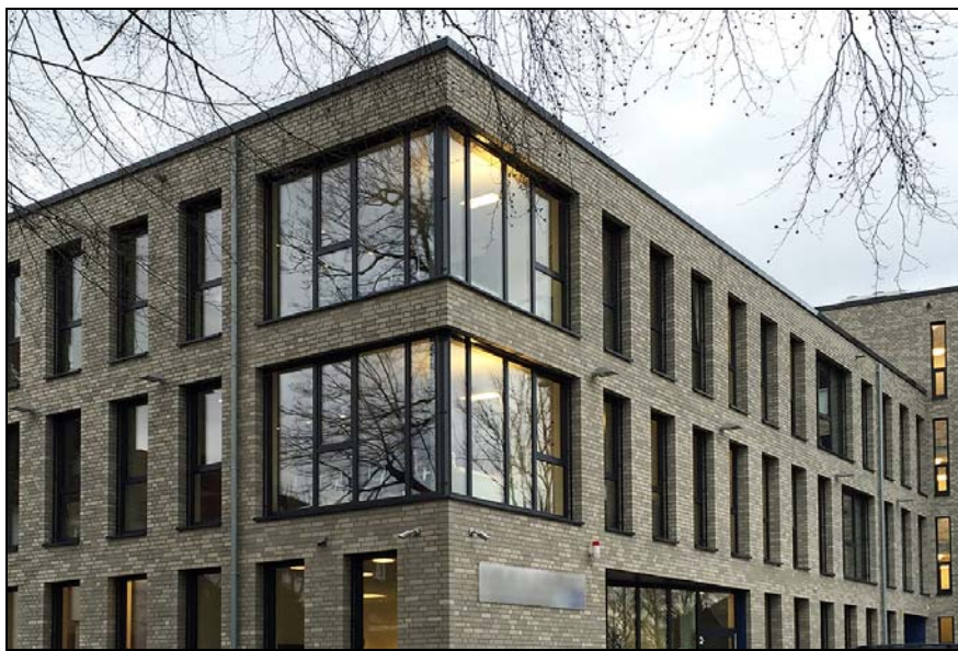
Hohe Anforderungen an den Wärme- und Schallschutz sowie im Design wurden auch beim Bau eines Wohn- und Geschäftsgebäudes in Lünen gestellt. Die Josef Baumeister GmbH aus Borken realisierte die 110 Kunststofffenster mit dem „System 76“.
